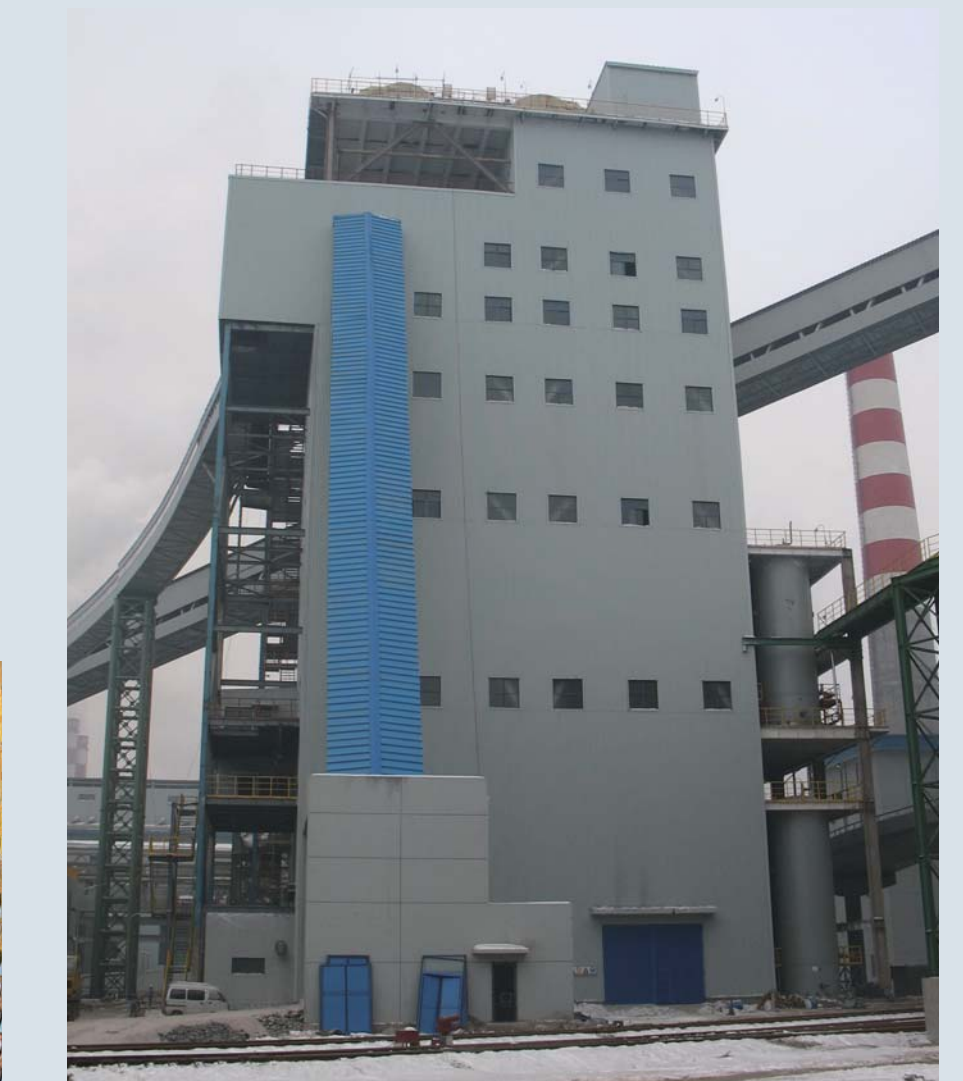
首钢迁钢3号高炉喷煤系统 PCI system for Shougang Qiangang 3# BF
