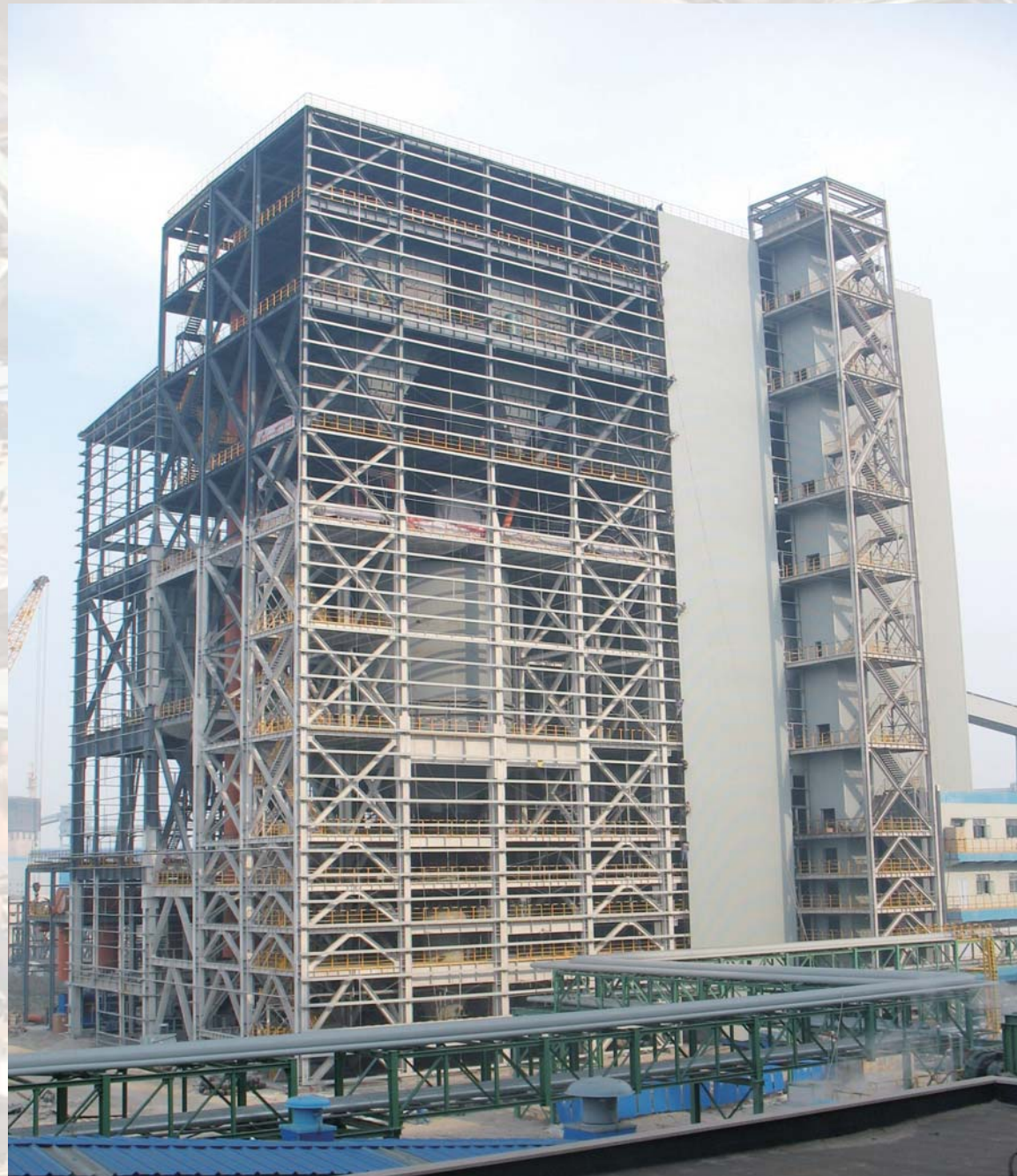
首钢京唐1号、2号高炉喷煤系统
