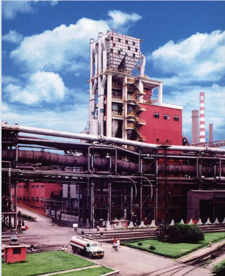
首钢2号、3号高炉喷煤系统 PCI systems for Shougang 2#,3# BFs
