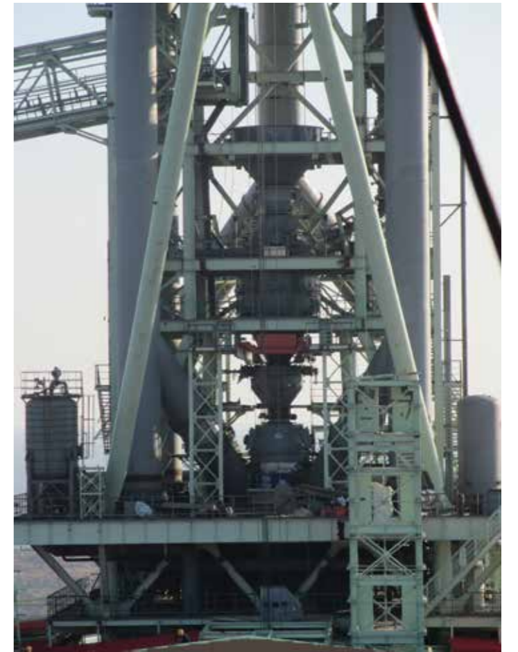
炉顶设备现场调试完成
