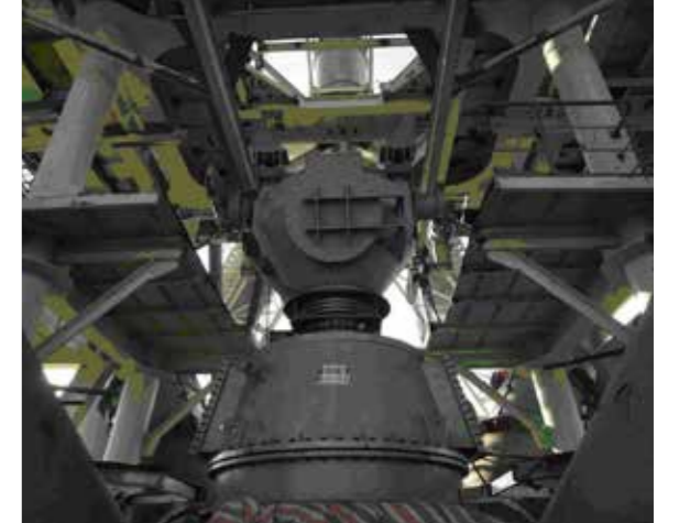
炉顶设备现场安装
