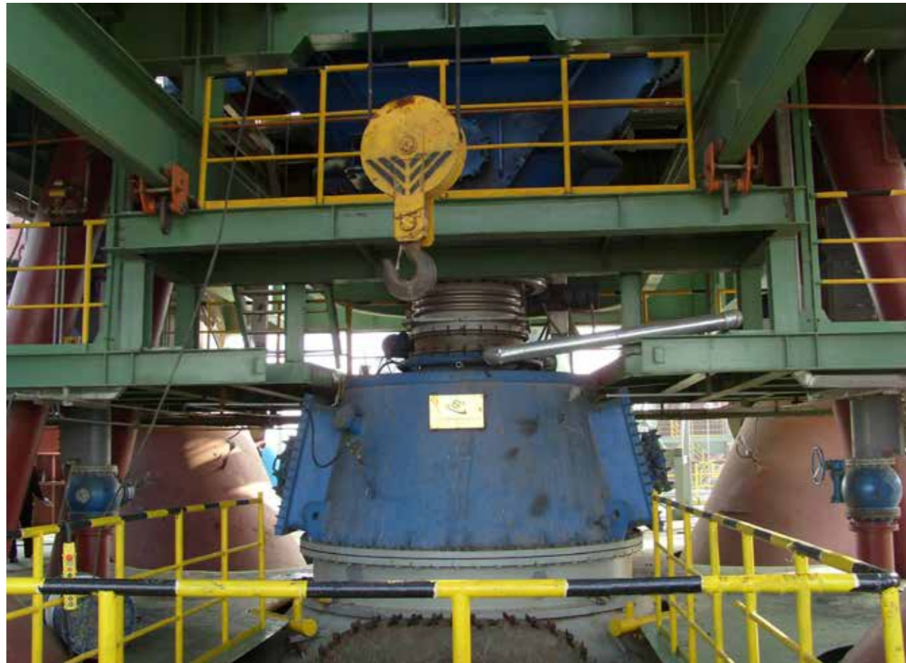
京唐5500 m 3 高炉炉顶设备现场安装
