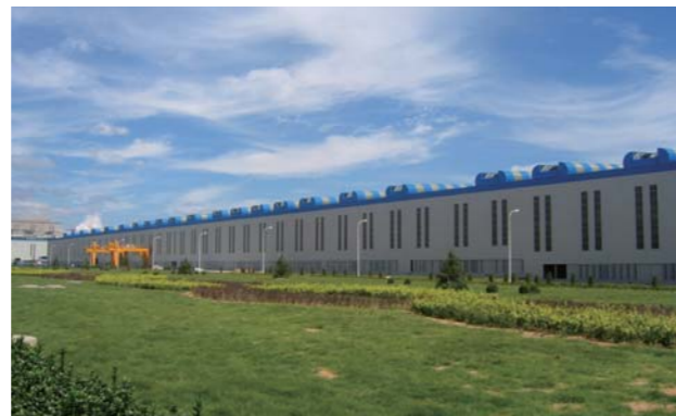
4300mm宽厚板生产线主厂房外景
