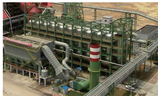
世界首例1000m 3 以上大型高炉煤气全干法低压脉冲布袋除尘系统
