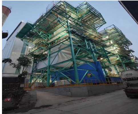
迁钢公司二烧脱硫脱硝系统优化项目
