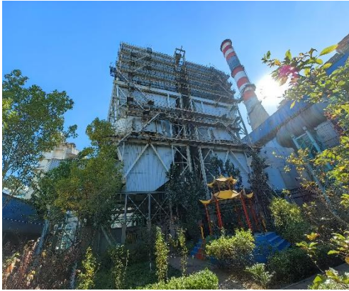
迁钢公司三烧脱硝提升项目
