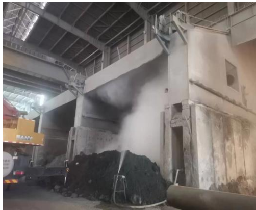
京唐公司钢轧泼渣池除尘罩改造
